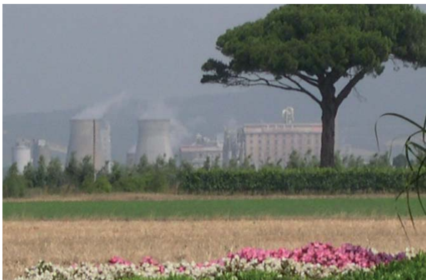
Stabilimento produttivo del Gruppo Solvay fondato nel 1863
